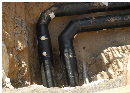
Spoj předizolovaného potrubí s propojením kontrolních vodičů (vlevo) a po montáži manžety a zapěnění
