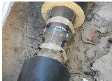
Spoj předizolovaného potrubí s propojením kontrolních vodičů (vlevo) a po montáži manžety a zapěnění
