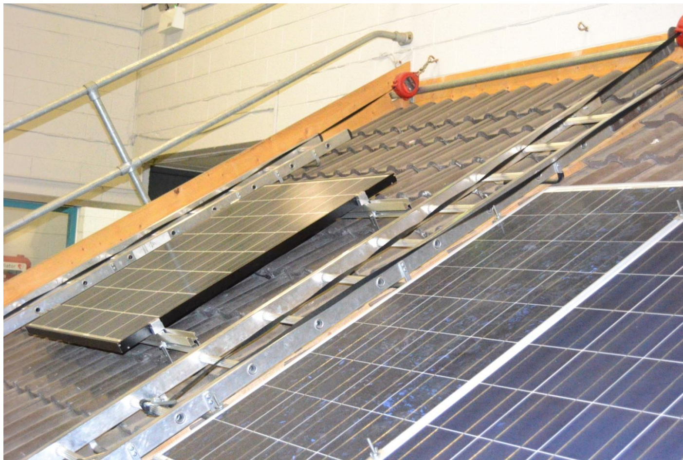
Střešní fotovoltaické panely
