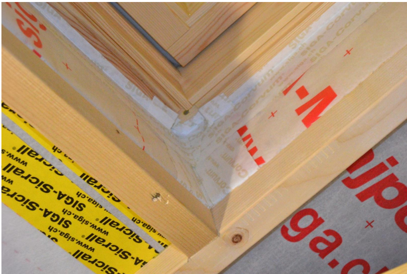
Detail vzduchotěsného oblepení rámu střešního okna
