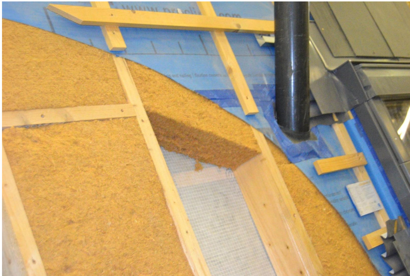
Model zateplení střešní konstrukce
