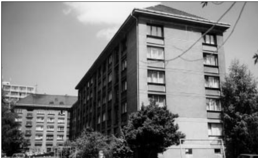
Energetický audit prošetřil i tento kladenský řadový bytový dům s rohovou sekcí. Typ T16 byl postaven v roce 1957 a je v něm 66 bytů a komerční prostory. Měrná spotřeba energie na vytápění dosahuje 170 kWh/m 2 *rok. Bez ohledu na náklady by bylo možno uspořit až 42 procent ročních nákladů.
