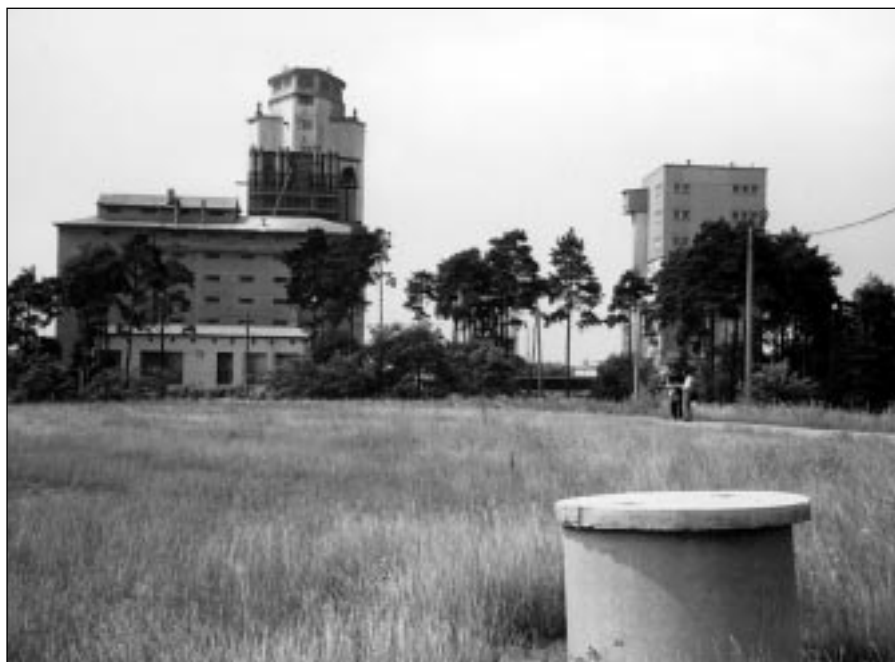
Skládka v Hodoníně budí na první pohled dojem rozlehlé louky. Jen betonové skruže studní jímajících bioplyn prozrazují, co se skrývá pod povrchem. Vzdálenost ke spotřebiteli energie v areálu obilního síla se počítá jen na desítky metrů.
