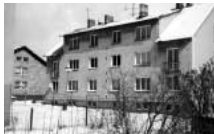
Obecní objekty byly postaveny do roku 1981 a mají s výjimkou Obecního úřadu velmi špatnou tepelnou izolaci. V každém bytovém domě je devět nájemních bytů. Stav před zateplením fasády. Po zateplení je na fasádě 8 cm polystyrenu Baumit a na střeše 12 cm minerální vlny.
