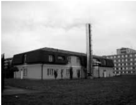
Zdroj tepla v Benátkách nad Jizerou vypadá mezi panelovými domy spíše jako luxusní sanatorium, nebo podnikatelská vila. Je to příjemná změna – kotelna nemusí být vždy ošklivá a špinavá.
