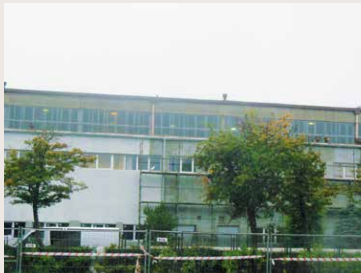
Administrativní budova během renovace | Photo: BAPE
