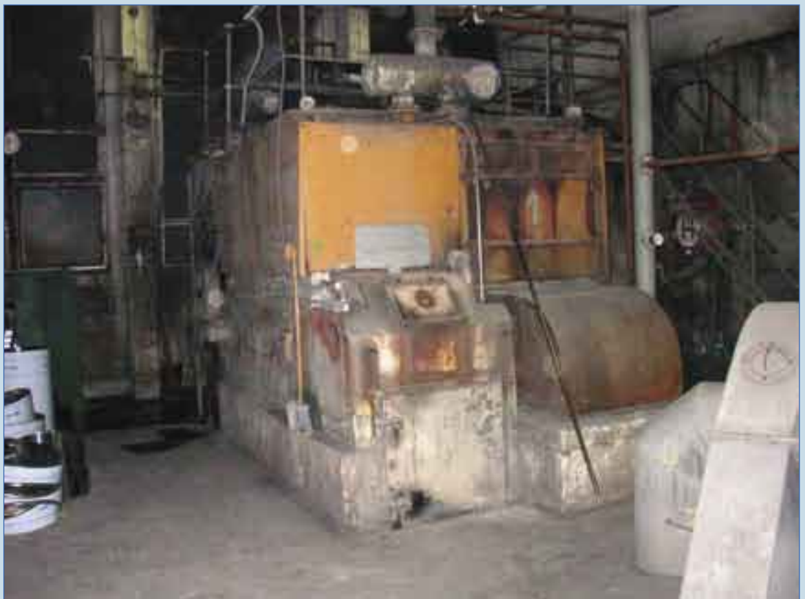
Horažďovice. Kotelna před rekonstrukcí Horažďovice. Boiler house before reconstruction
