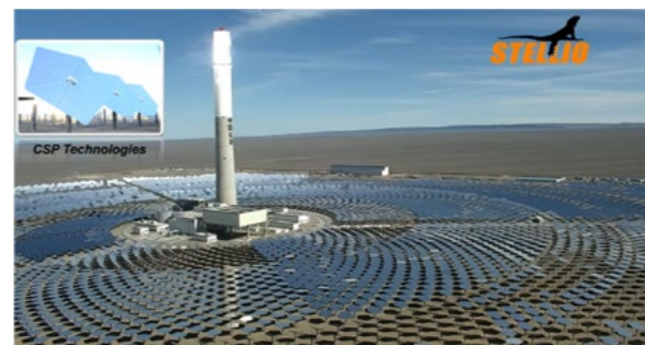
Věž Stellio, Hami / Kumul v Číně je obklopena 14,5 tisíci heliostaty.
