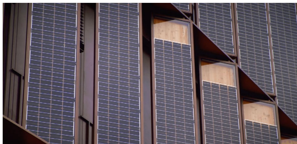
Vertikální lamela s integrovanou fotovoltaikou slouží zároveň jako stínící žaluzie.
