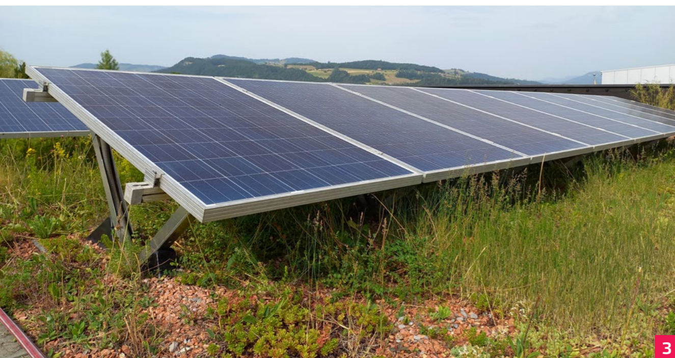
Orientace panelů k jihu na vyvýšené konstrukci. (Zdroj: archiv autora)
