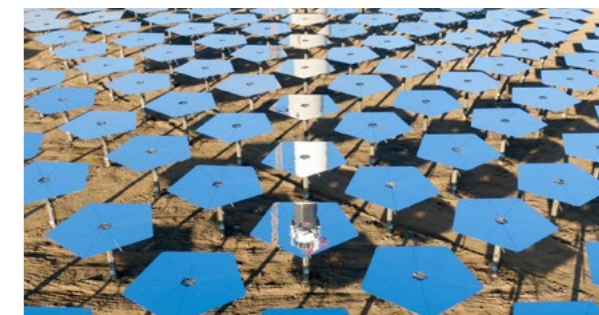
Každý pětiúhelníkový heliostat je vyroben z plaveného postříbřeného skla.
