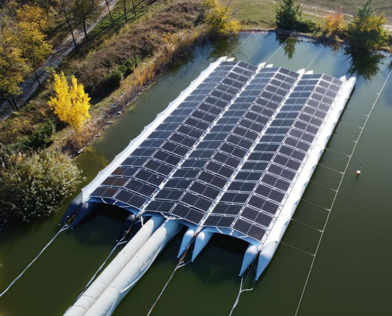
Blowfish – membránové nafukovací trubky nesou oboustranné fotovoltaické články.
