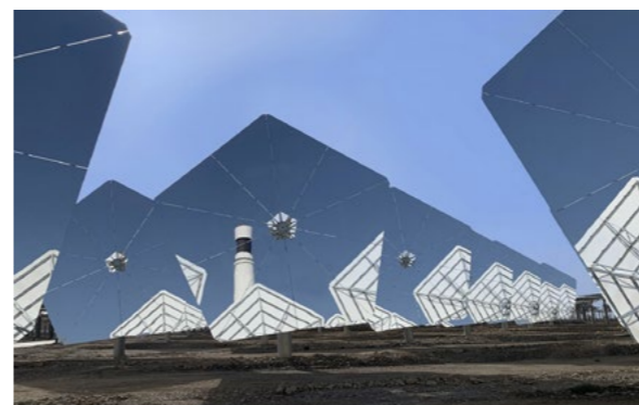
Heliostat se skládá z 11 segmentů.
