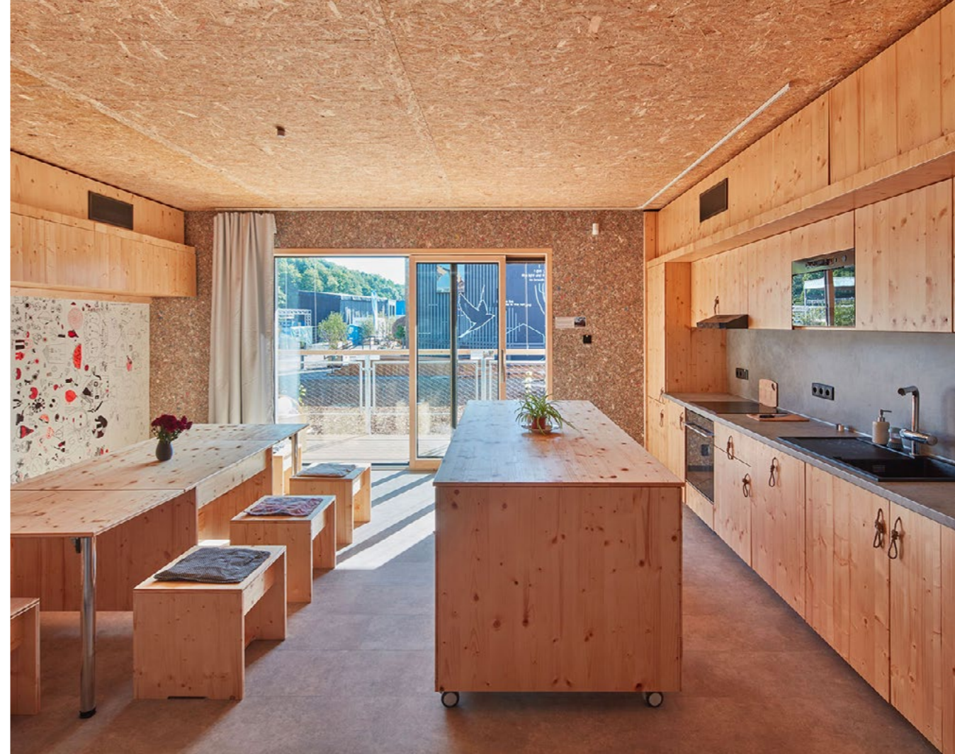
Vnitřní povrch stěn domu FIRSTLIFE tvoří desky z lisovaných nápojových kartonů. Interiér a dřevěný nábytek byl navržen tak, aby umožnil variabilní využití prostoru.
