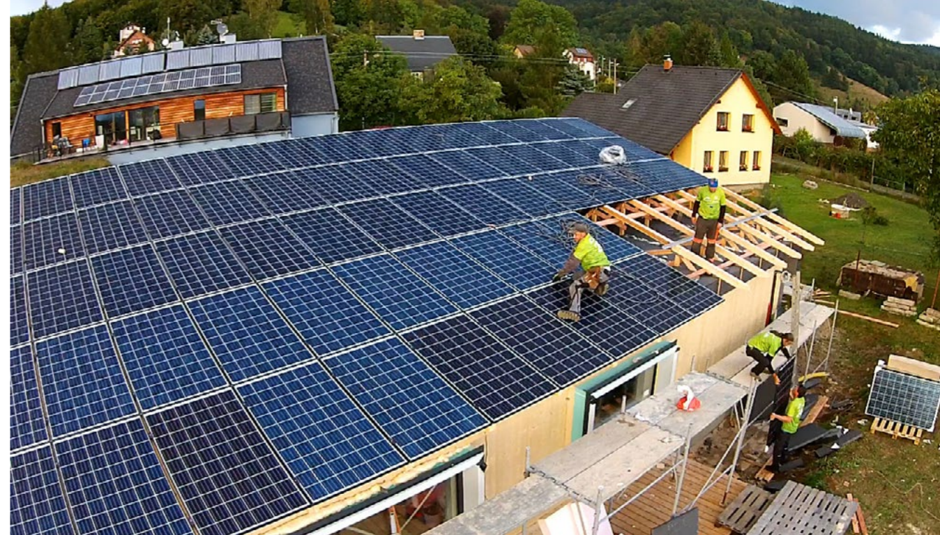
Střechu tvoří pouze fotovoltaické panely instalované přímo na krov.
