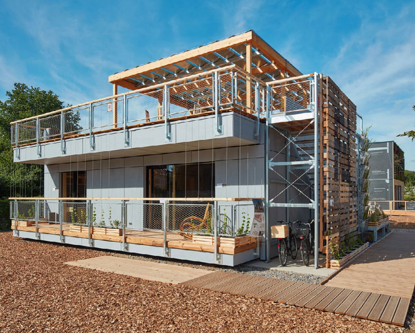
Nosnou konstrukci soutěžního domu FIRSTLIFE tvoří dřevěný sloupkový systém doplněný izolací z foukané celulózy a dřevovláknitých desek.
