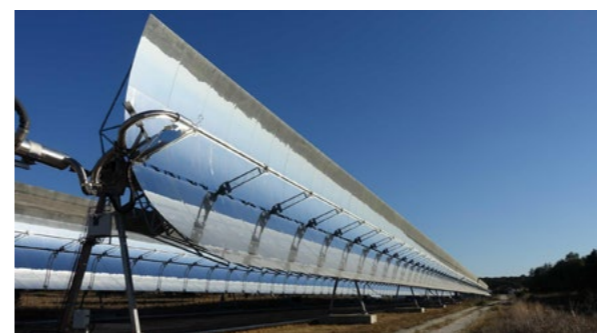
Španělská elektrárna Andasol 3 s 684 m dlouhou řadou parabolických slunečních kolektorů.
