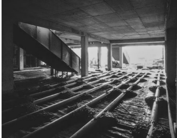
Zemní výměník tepla ve výstavbě, asi 1986.
