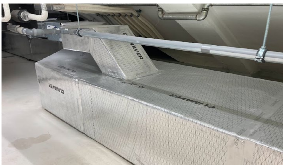
Nízká hmotnost ulehčuje práci nejen při výrobě potrubí, ale také při instalaci potrubí ve stísněných prostorech.
