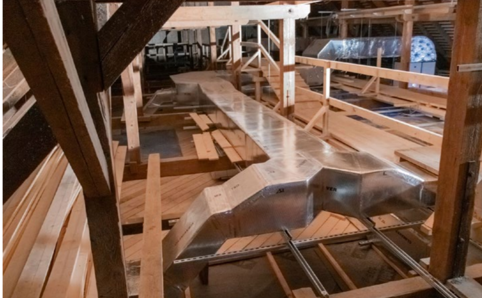
Flexibilita systému CLIMAVER® umožnila realizaci rozvodů vzduchotechniky bez nutných zásahů v krovu a stropu.
