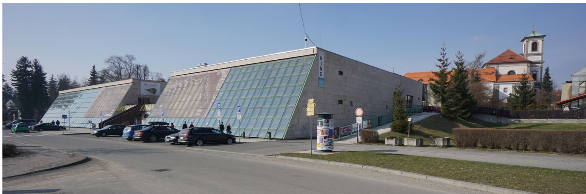
Jednoduché zasklení jižní fasády kryje nuceně provětrávanou dutinu. V ní se nacházejí oboustranně ofukované teplosběrné desky z černého opakního skla, které pomáhají pohlcovat sluneční záření. (Foto: archiv Jiřího Suchomela, asi 2011)
