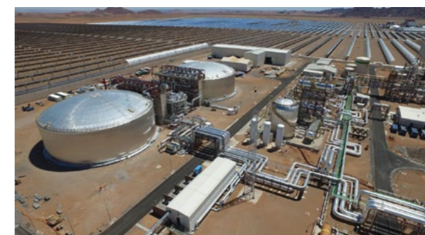
Žlabové kolektory lze přizpůsobit prudkému větru. Speciální konstrukce má i fotovoltaická elektrárna v Urat v Mongolsku.
