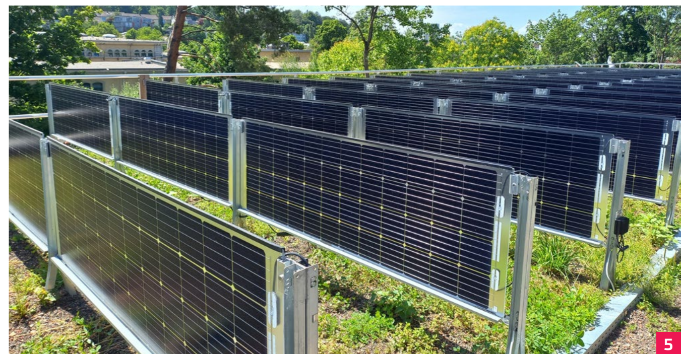
Bifaciální FV panely na zelené střeše s lučnými bylinami a travinami. (Zdroj: archiv autora)
