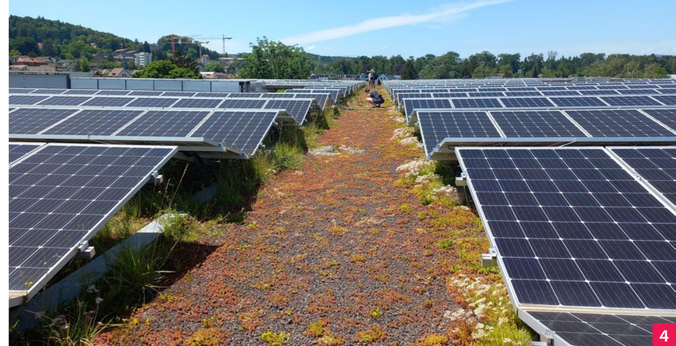
Orientace panelů východ-západ na vyvýšené konstrukci. (Zdroj: archiv autora)
