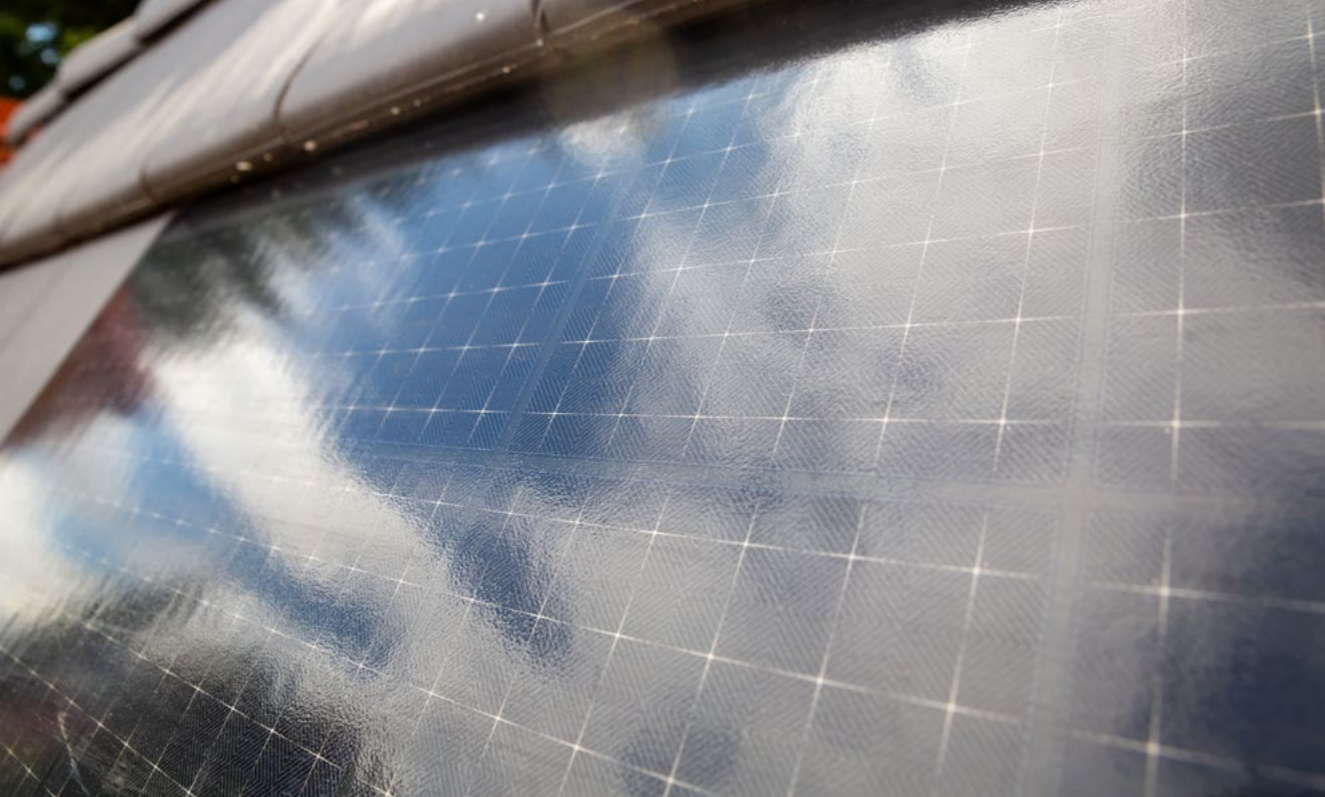
Detail fotovoltaické střešní krytiny.
