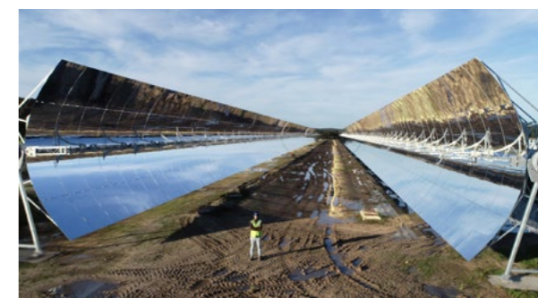
HPS2 v Évoře využívá žlabových kolektorů typu HelioTrough, které mají vysokou optickou účinnost a nižší náklady.
