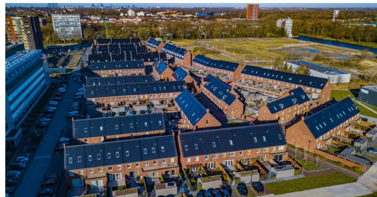
Fotovoltaické moduly vizuálně tolik neruší vzhled budov. V blízké době budou také v barvě terakoty.
