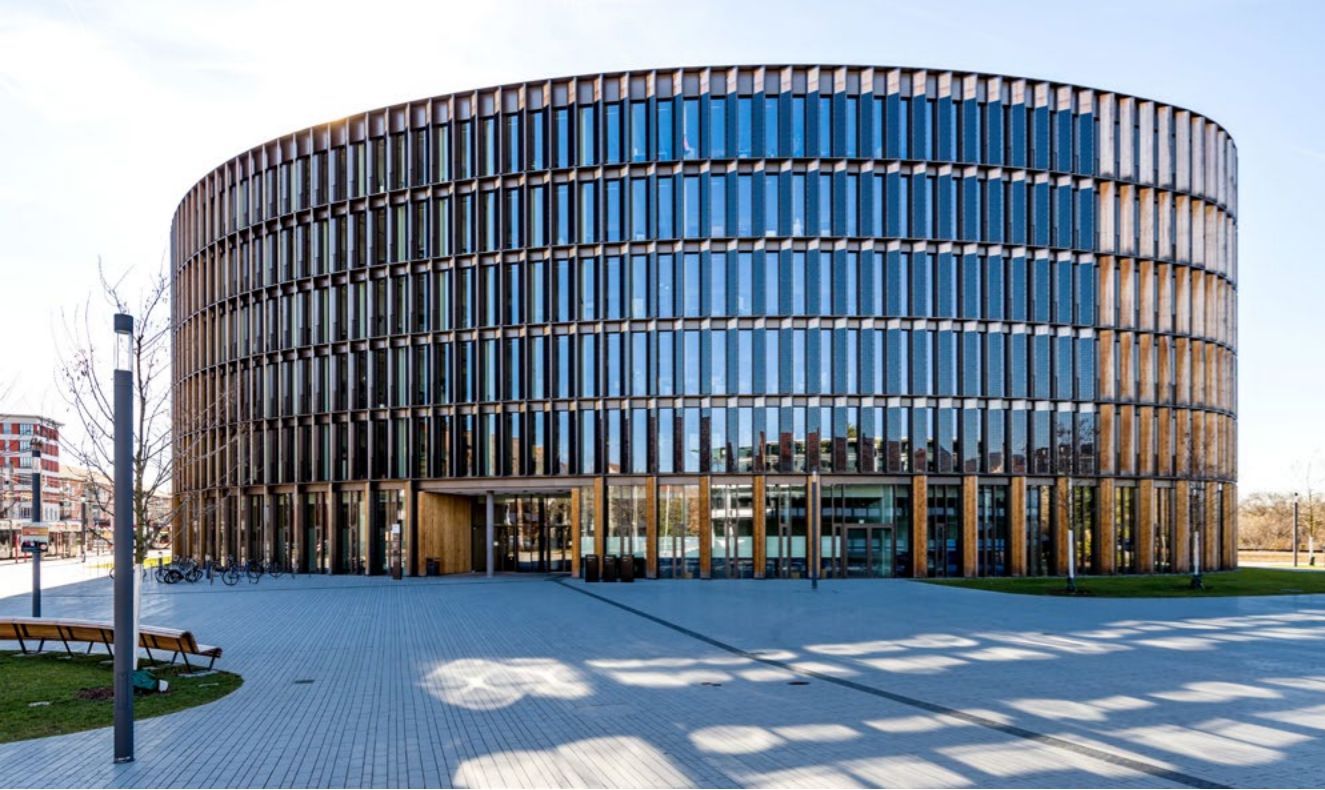
Budova radnice je další v řadě mnoha staveb realizovaných v duchu freiburské „laboratoře německé zelené architektury“.
