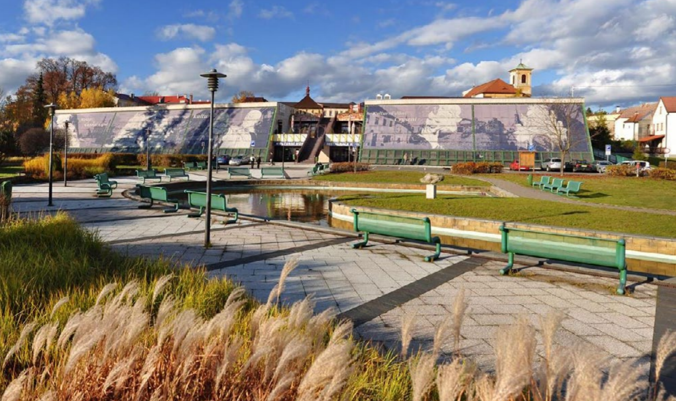
Ocelová konstrukce jižní fasády s tepelně izolačními výplněmi má plochu cca 800 m 2 a sklon 30°. (Foto: archiv Jiřího Suchomela)
