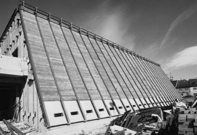
Jižní fasáda ve výstavbě. (Foto: archiv Jiřího Suchomela, asi 1986)
