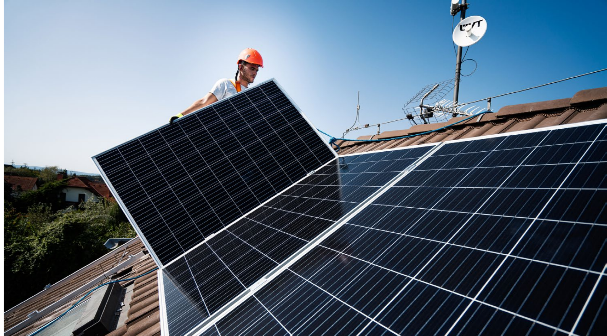
Montáž u šikmých střech je bezproblémová, když je použita pálená či betonová taška nebo falcový plech.
