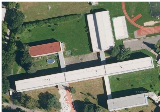
Obrázek 5 - Pohled na budovu, roviny střech (Objekt č. 5)
