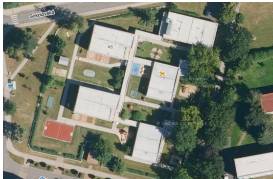
Obrázek 11 - Pohled na budovu, roviny střech (Objekt č. 11)
