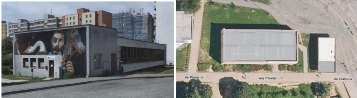
Obrázek 2 - Pohled na budovu, roviny střech (Objekt č. 2)
