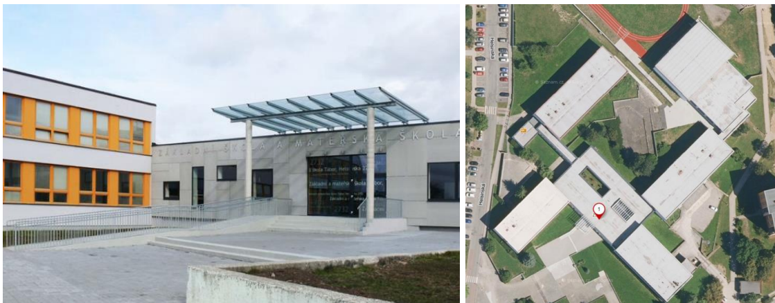
Obrázek 4 - Pohled na budovu, roviny střech (Objekt č. 4)
