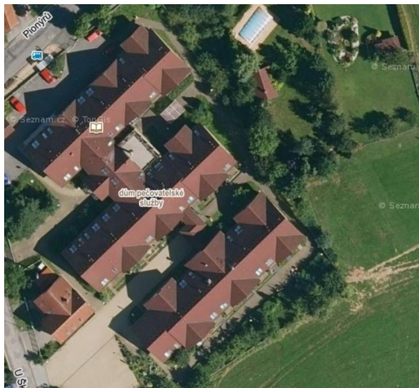
Obrázek 13 - Pohled na budovu, roviny střech (Objekt č. 13)
