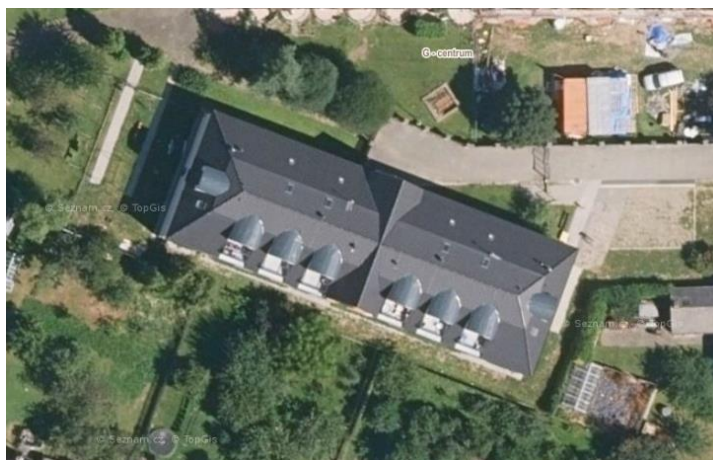
Obrázek 14 - Pohled na budovu, roviny střech (Objekt č. 14)
