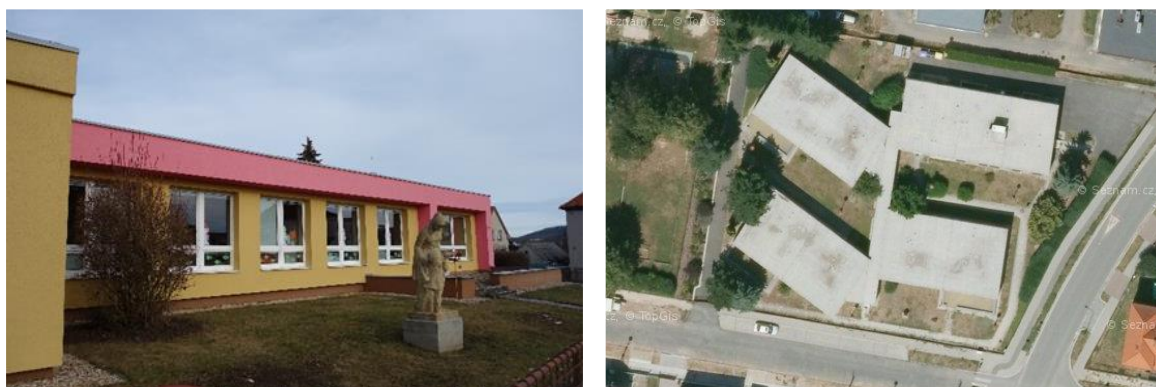
Obrázek 19 - Pohled na budovu, roviny střech (Objekt č. 18)
