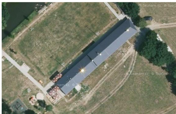
Obrázek 12 - Pohled na roviny střech (Objekt č. 12)
