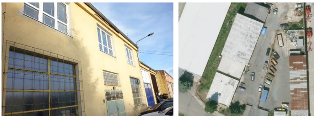
Obrázek 24 - Pohled na budovu, roviny střech (Objekt č. 23)
