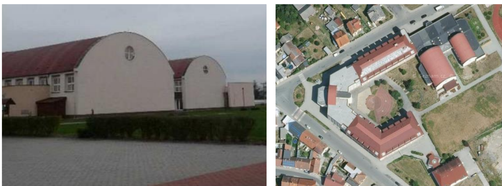
Obrázek 14 - Pohled na budovu, roviny střech (Objekt č. 13b)
