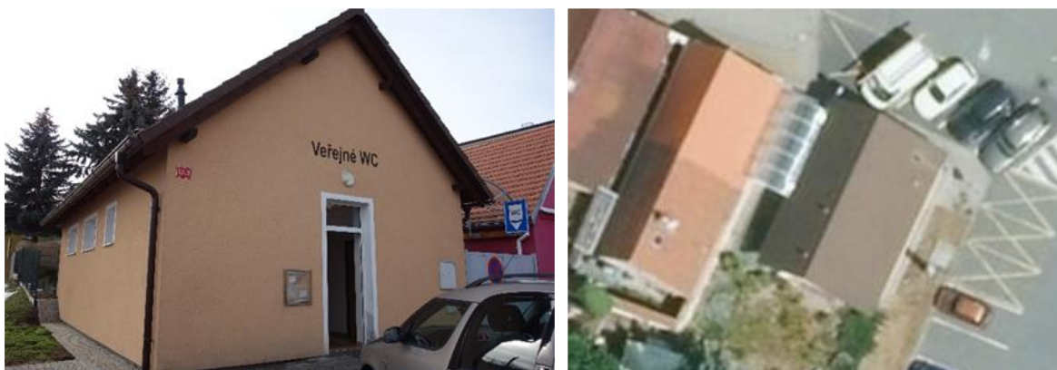
Obrázek 10 - Pohled na budovu, roviny střech (Objekt č. 10)
