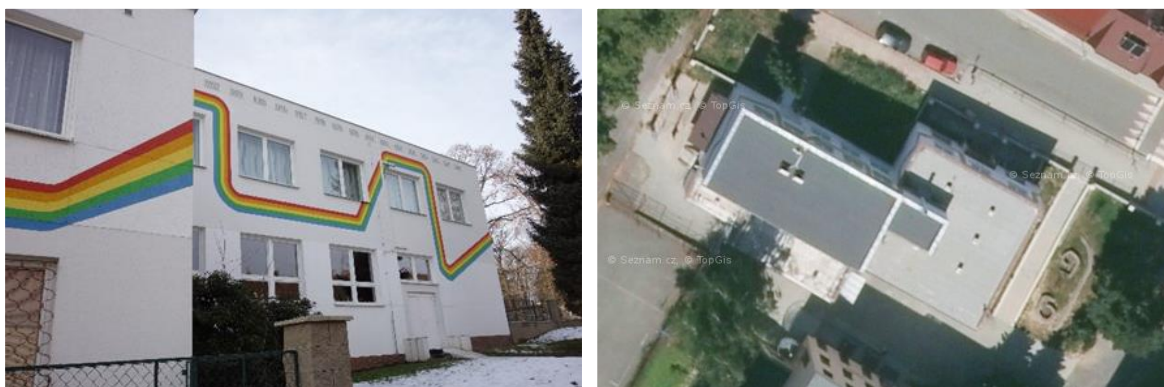
Obrázek 20 - Pohled na budovu, roviny střech (Objekt č. 19)
