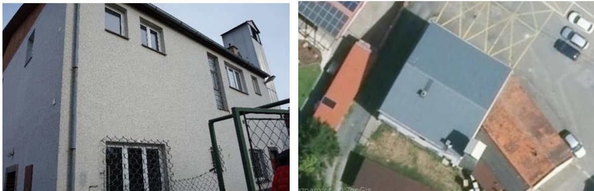
Obrázek 9 - Pohled na budovu, roviny střech (Objekt č. 9)
