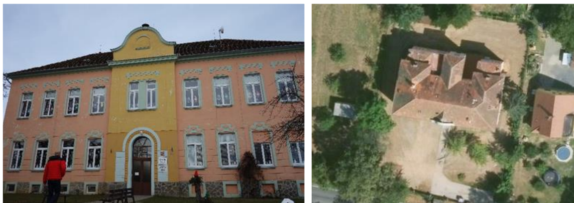
Obrázek 17 - Pohled na budovu, roviny střech (Objekt č. 16)
