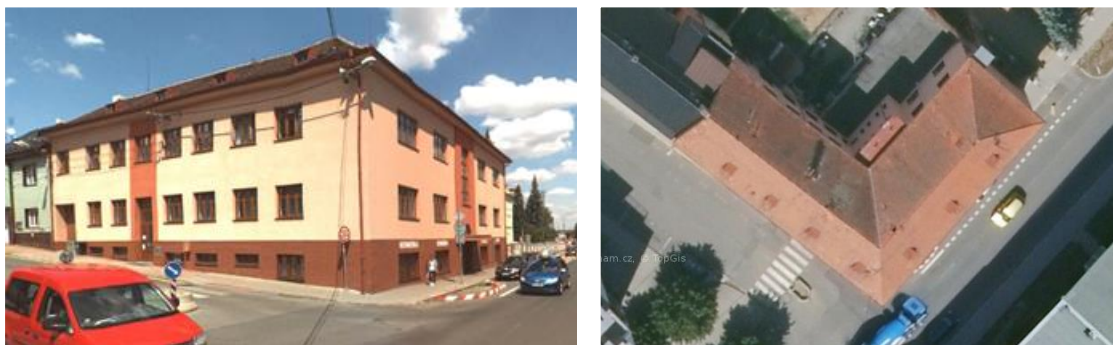
Obrázek 23 - Pohled na budovu, roviny střech (Objekt č. 22)
