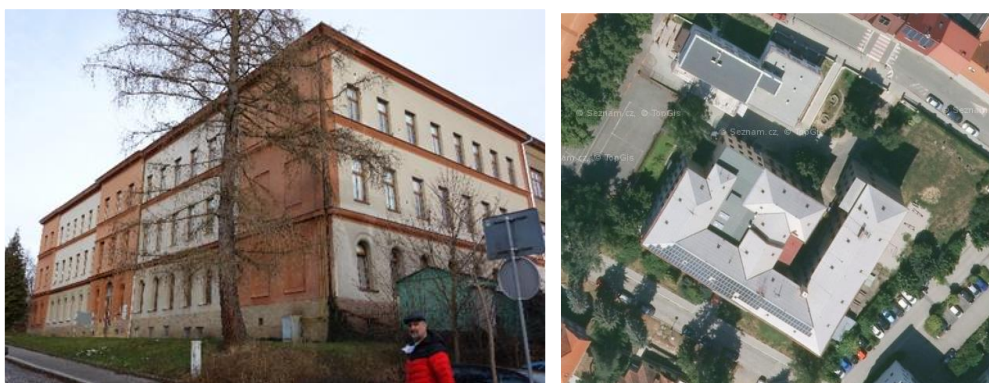
Obrázek 15 - Pohled na budovu, roviny střech (Objekt č. 14)
