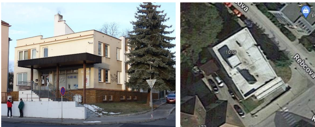
Obrázek 3 - Pohled na budovu, roviny střech (Objekt č. 3)
