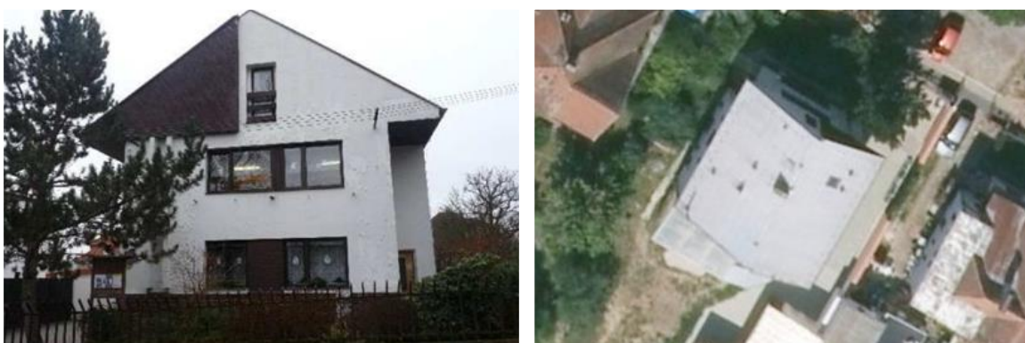
Obrázek 8 - Pohled na budovu, roviny střech (Objekt č. 8)
