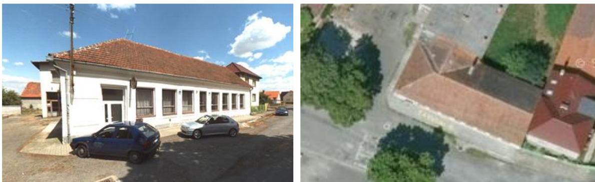
Obrázek 28 - Pohled na budovu, roviny střech (Objekt č. 27)
