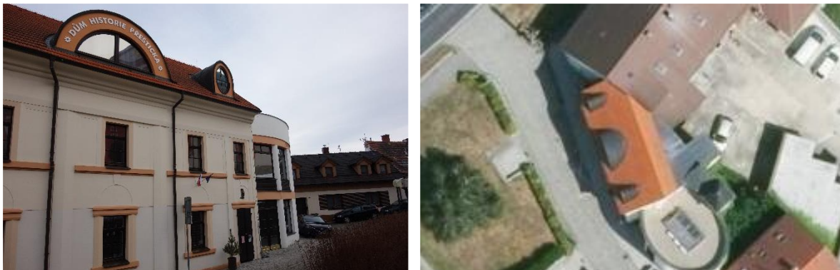
Obrázek 6 - Pohled na budovu, roviny střech (Objekt č. 6)
