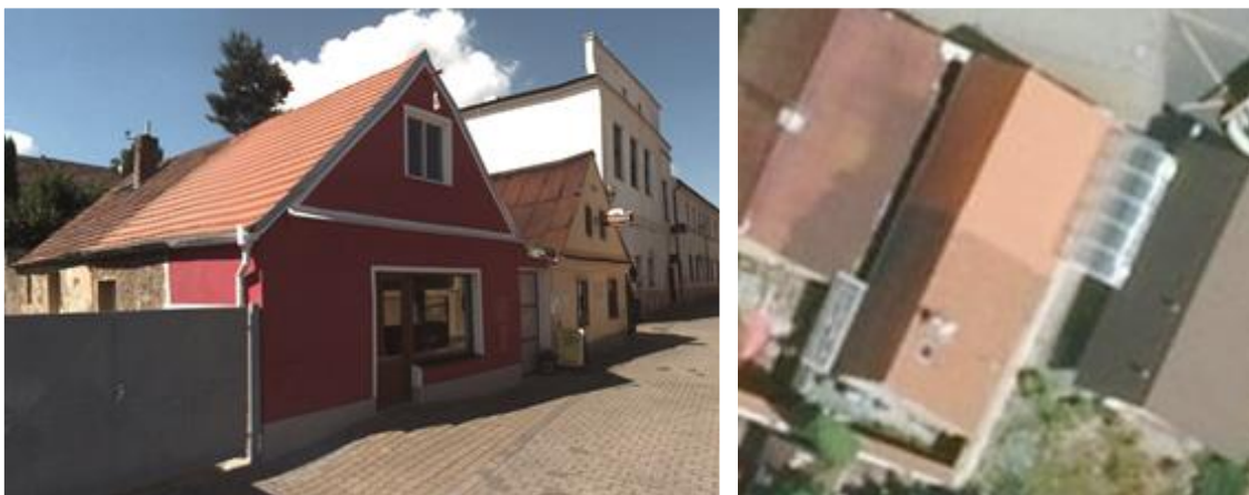
Obrázek 26 - Pohled na budovu, roviny střech (Objekt č. 25)
