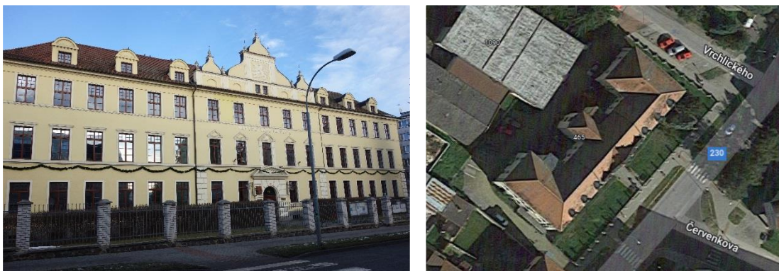
Obrázek 2 - Pohled na budovu, roviny střech (Objekt č. 2)
