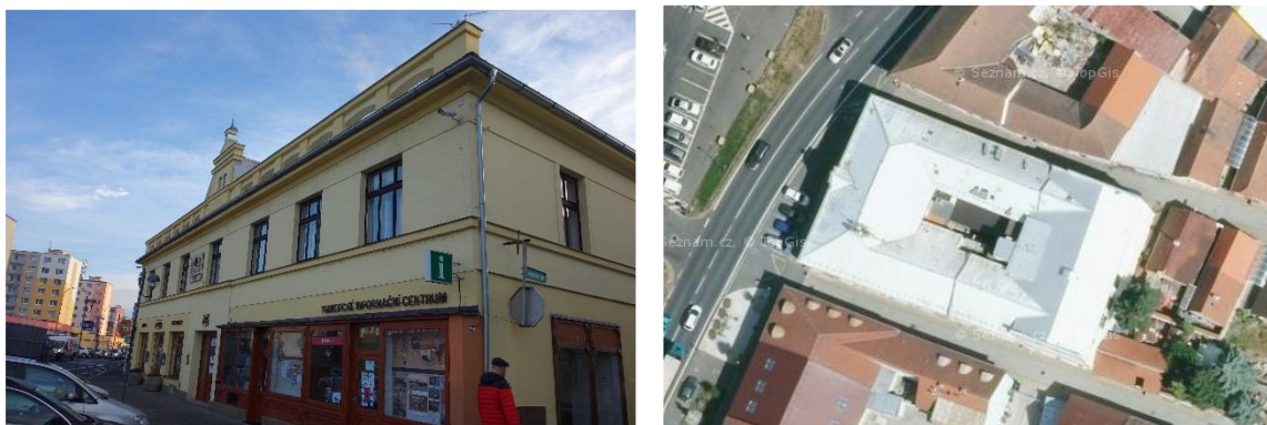
Obrázek 5 - Pohled na budovu, roviny střech (Objekt č. 5)
