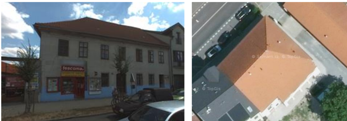
Obrázek 29 - Pohled na budovu, roviny střech (Objekt č. 28)
