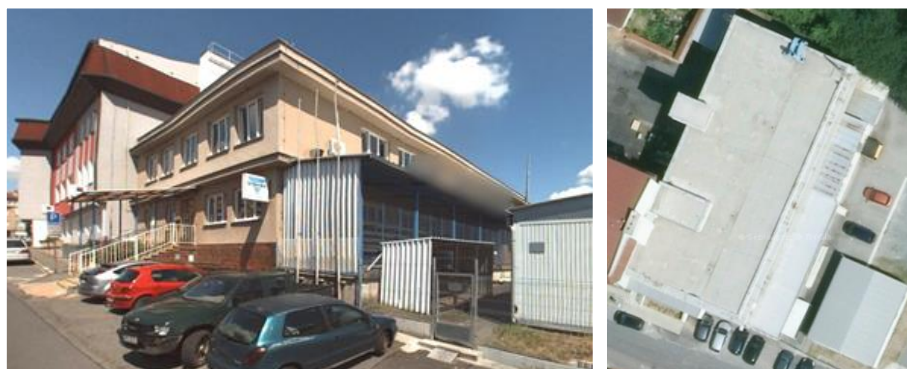
Obrázek 25 - Pohled na budovu, roviny střech (Objekt č. 24)
