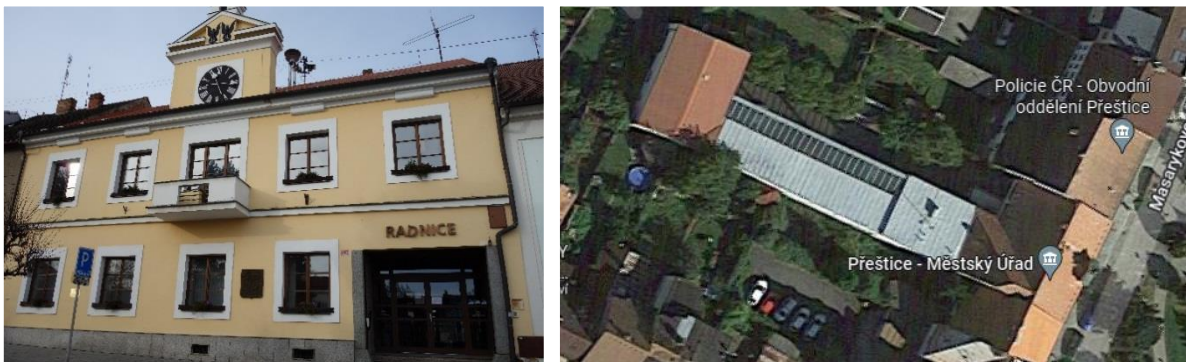
Obrázek 1 - Pohled na budovu, roviny střech (Objekt č. 1)
