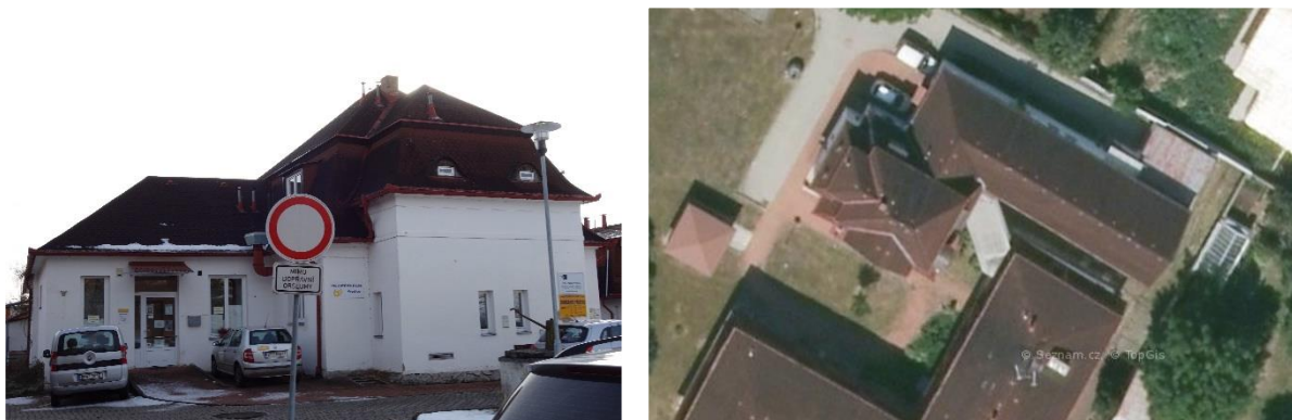
Obrázek 4 - Pohled na budovu, roviny střech (Objekt č. 4)
