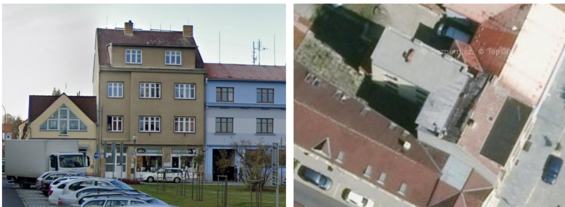
Obrázek 21 - Pohled na budovu, roviny střech (Objekt č. 20)
