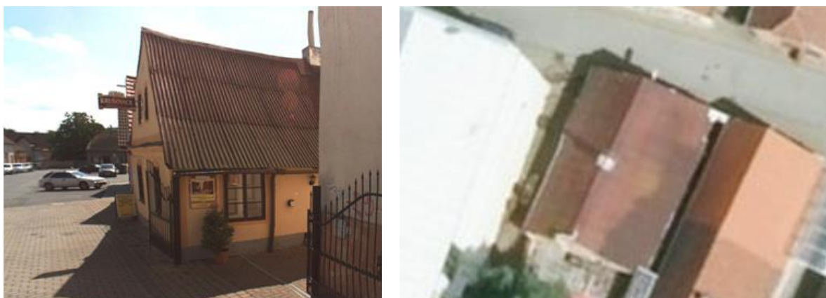
Obrázek 27 - Pohled na budovu, roviny střech (Objekt č. 26)
